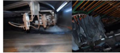
7. Hava tabancası ile boyama işlemi
